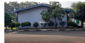
Gambar 10. Foto Gudang Arsip Setumau Tampak Samping
