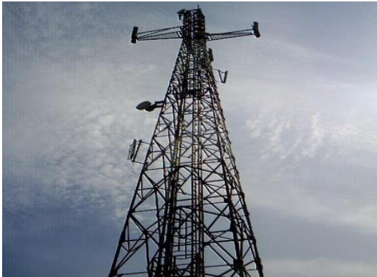
Gambar 4. Menara BTS (Sumber: http://id.wikipedia.org/wiki/Berkas:Menara_BTS.JPG )
